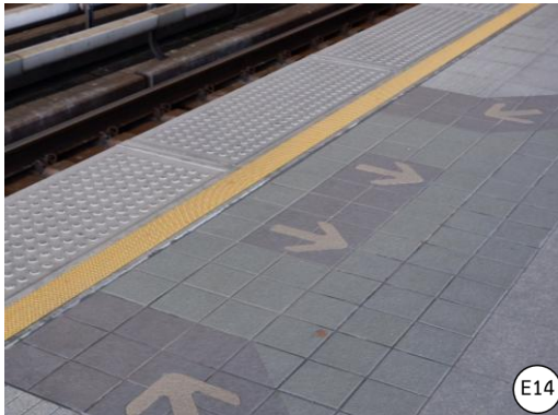
รูปที่ 2-38 แนวเส้นสีเหลืองและพื้นผิวขรุขระแสดงเขตห้ามล่ว่งล่า บริเวณสถานี E10-E14
