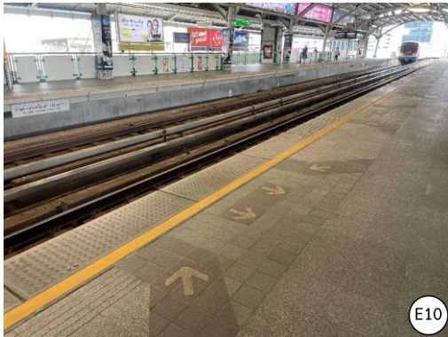
รูปที่ 2-38 แนวเส้นสีเหลืองและพื้นผิวขรุขระแสดงเขตห้ามล่ว่งล่า บริเวณสถานี E10-E14
